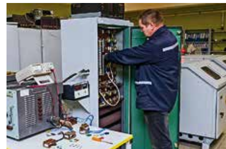
Проверяем двадцатиамперники. Сейчас настроим оборудование.
